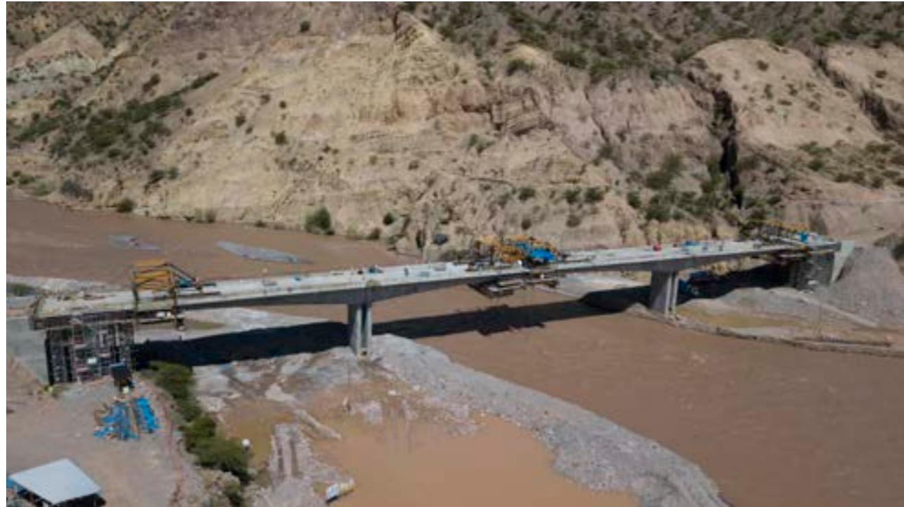
PUENTE ALLCCOMACHAY - CARRO DE AVANCE CVS
