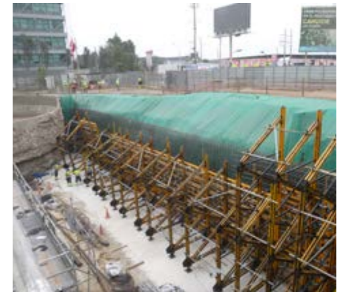
LÍNEA 2 DEL METRO DE LIMA
