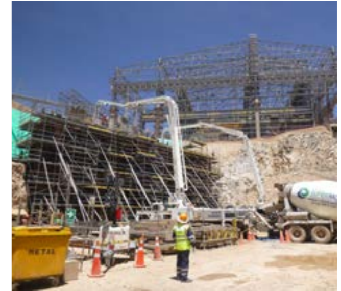
AMPLIACIÓN Y MONTAJE DE LA MINA TOQUEPALA
