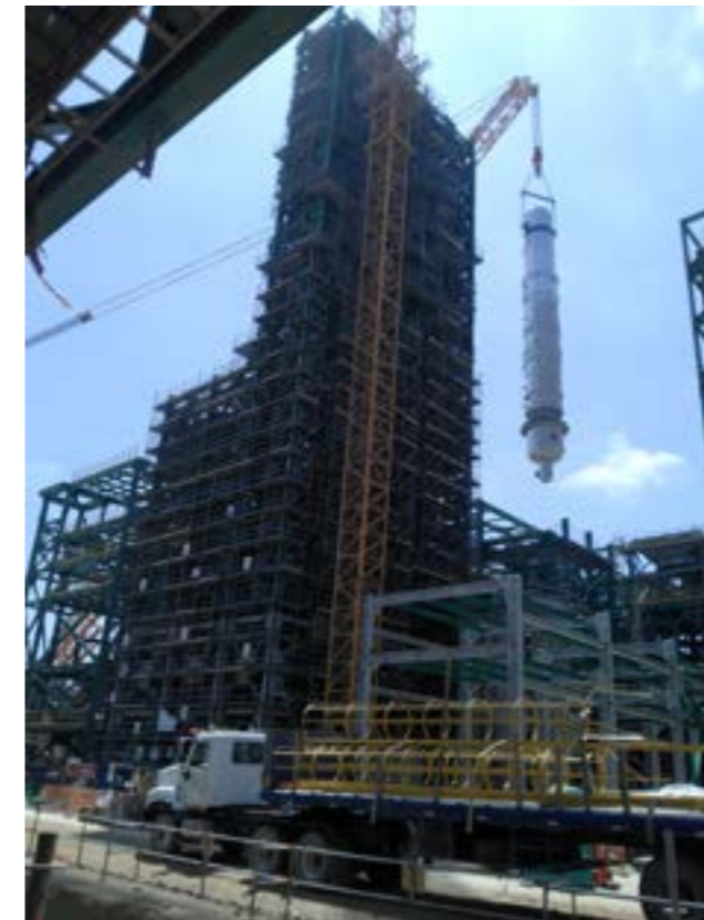
Andamio volumétrico de gran alcance en altura, confirmando su alta capacidad y estabilidad de sus componentes.
