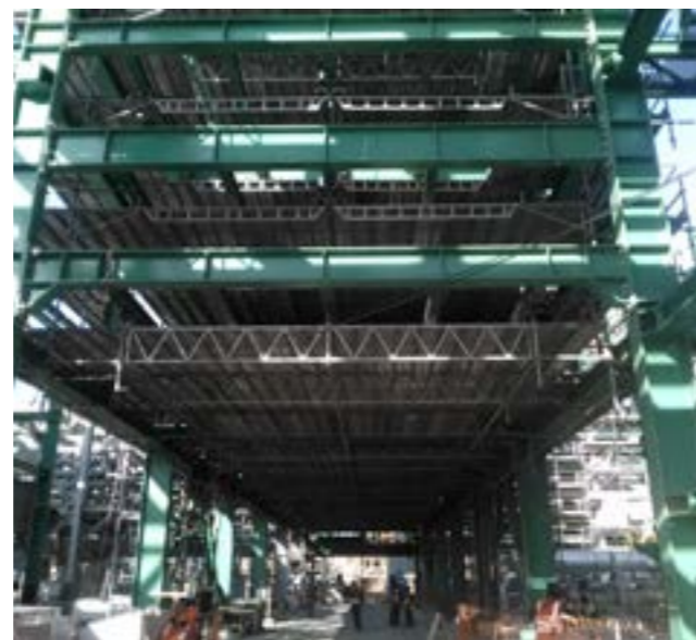
Andamio BRIO suspendido con diferentes niveles de plataforma para trabajos en simultáneo
