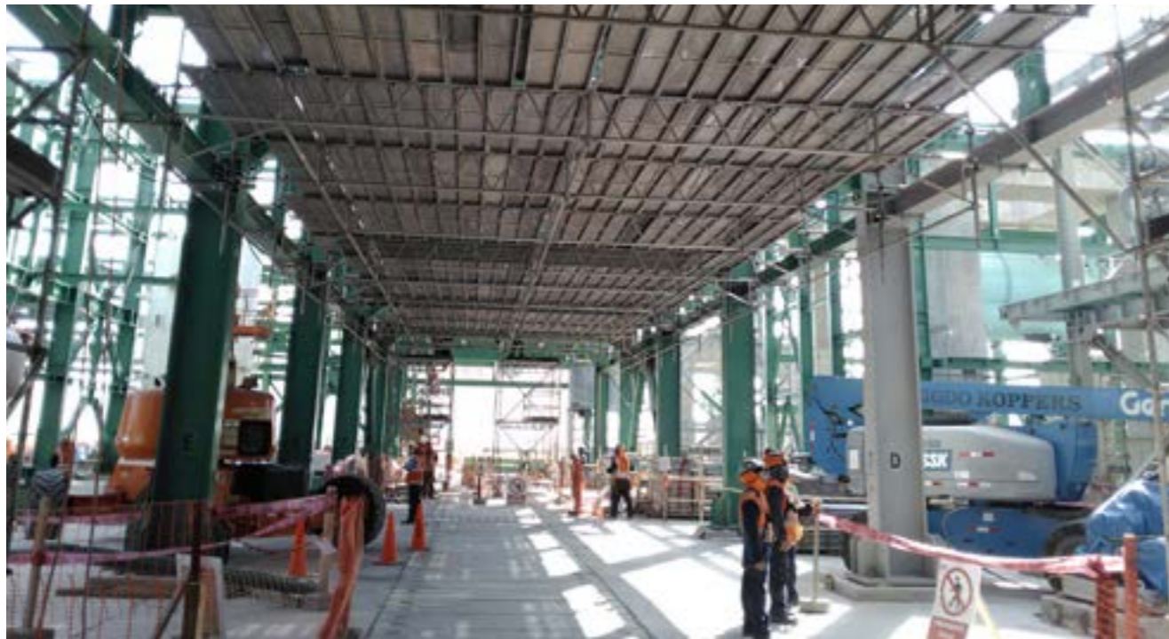
Plataforma suspendida y segura que permite el libre tránsito en los sectores de trabajo y acoplamiento del sistema BRIO con estructura metálica mediante tubos y abrazaderas IPN
