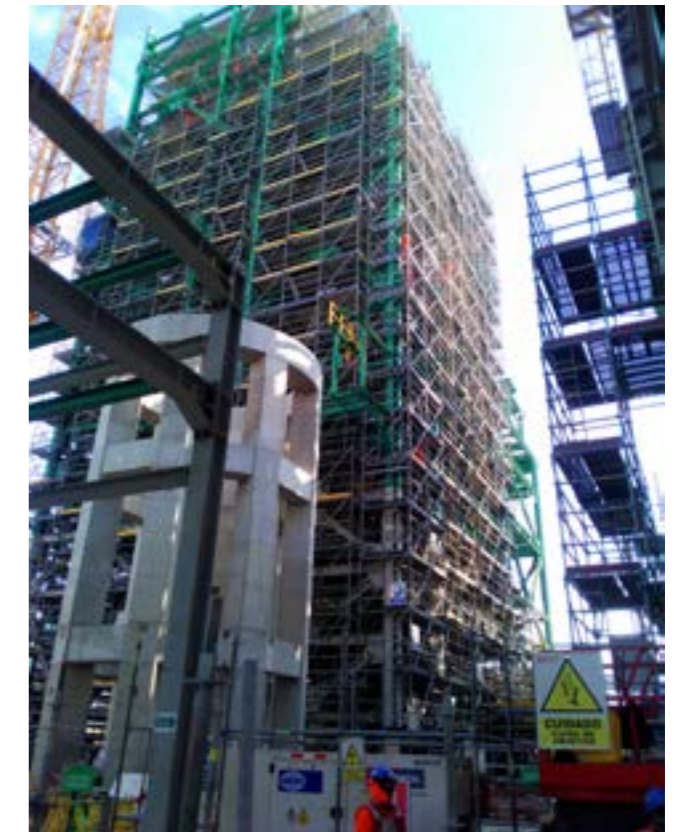
Andamio volumétrico de gran alcance en altura, confirmando su alta capacidad y estabilidad de sus componentes.
