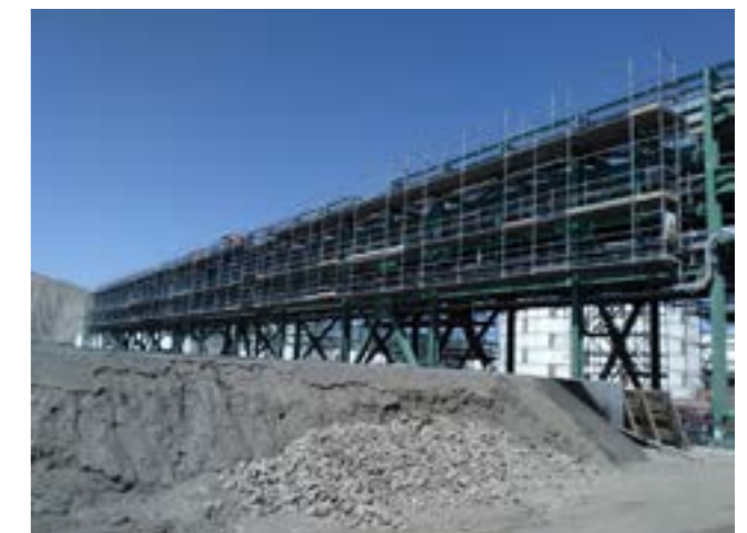
Plataforma en voladizo a lo largo de la estructura principal para ensamblaje y ajuste de tuberías
