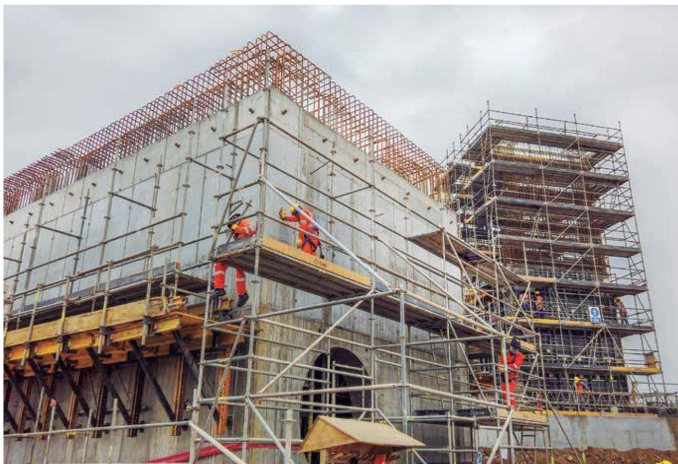
>>STOCKPILE Y CHANCADORA: son estructuras de concreto armado configurado estructuralmente por una gran cimentación, placas y losas pesadas. Presenta una geometría rectangular en planta.
