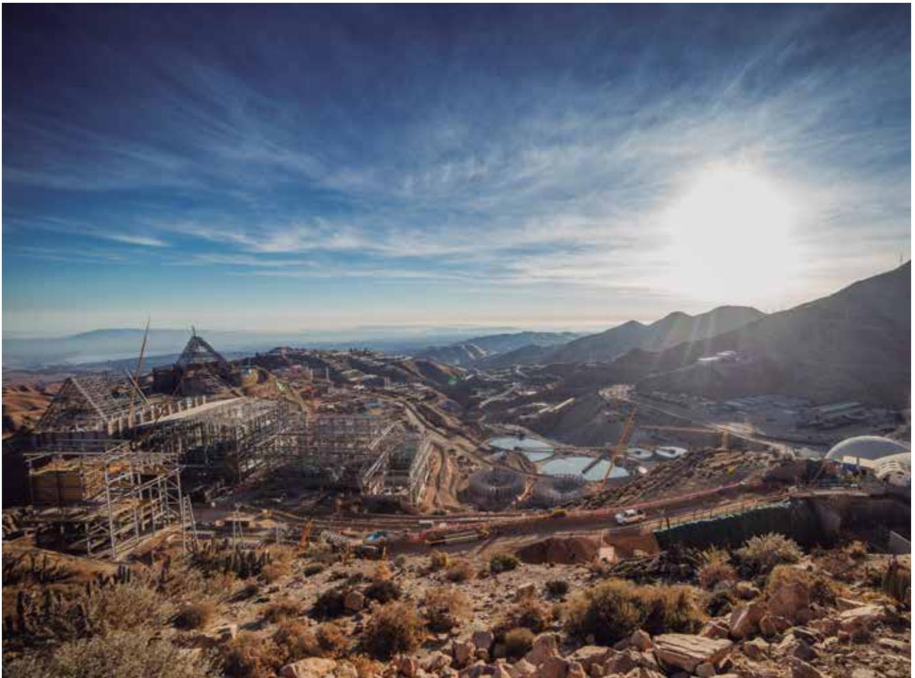
Se utiliza el encofrado NEVI para poder realizar los muros contrafuegos de 12 metros de alto y para encofrar las bases donde irán los espesadores. Se aplica también en las columnas y placas de los edificios HPGR y silos. Para la losa se utiliza el sistema de cimbra BRIO como apeo.
