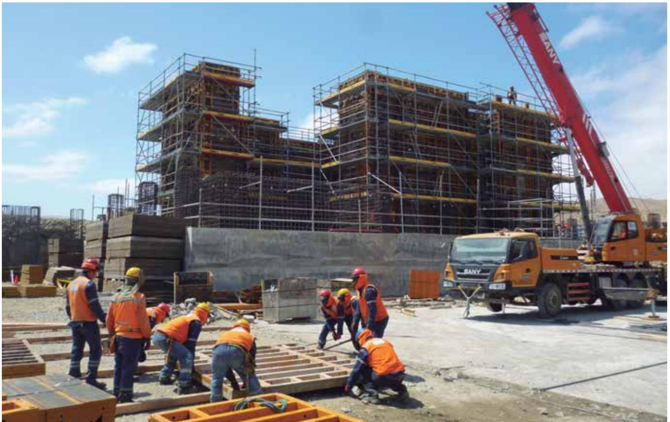
Fue de especial valor el andamio BRIO, por su adaptabilidad a todas las geometrías requeridas para facilitar las labores de ferrallado y vaciado de concreto.
