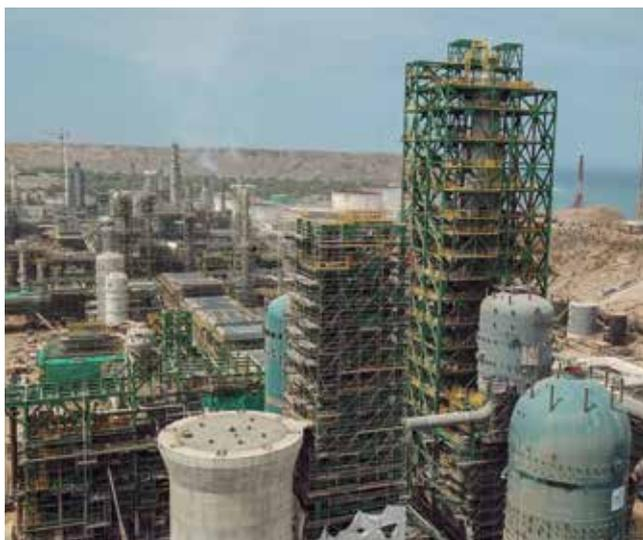
externos en los equipos a montar. En los racks se priorizó el uso de diversos puntos de cuelgue de la estructura principal con tubos y abrazaderas para evitar el uso de diagonales que interrumpiesen el tendido de tuberías.
